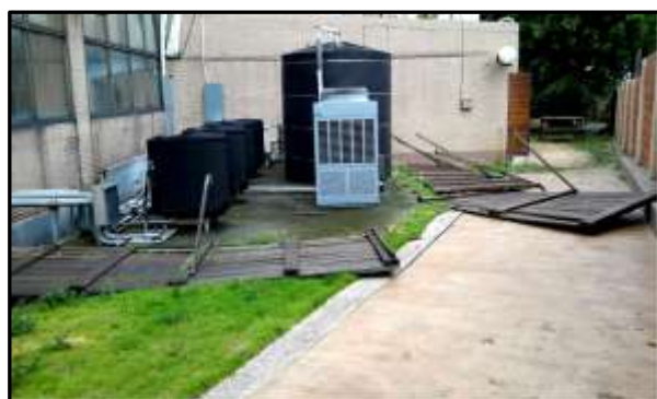
【游泳池熱泵圍籬倒塌】
